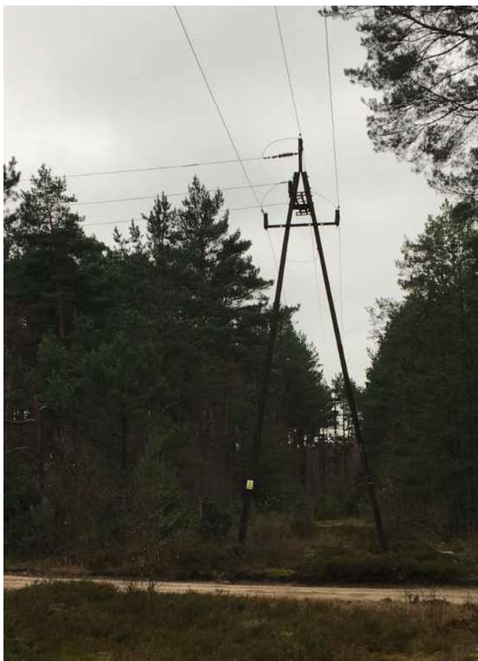
Rys.3 Istniejący słup nr 2 przeznaczony do wymiany
