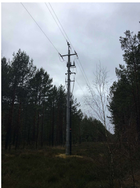
Rys.4 Istniejący słup nr 16 z zejściem kablowym do rozbiórki
